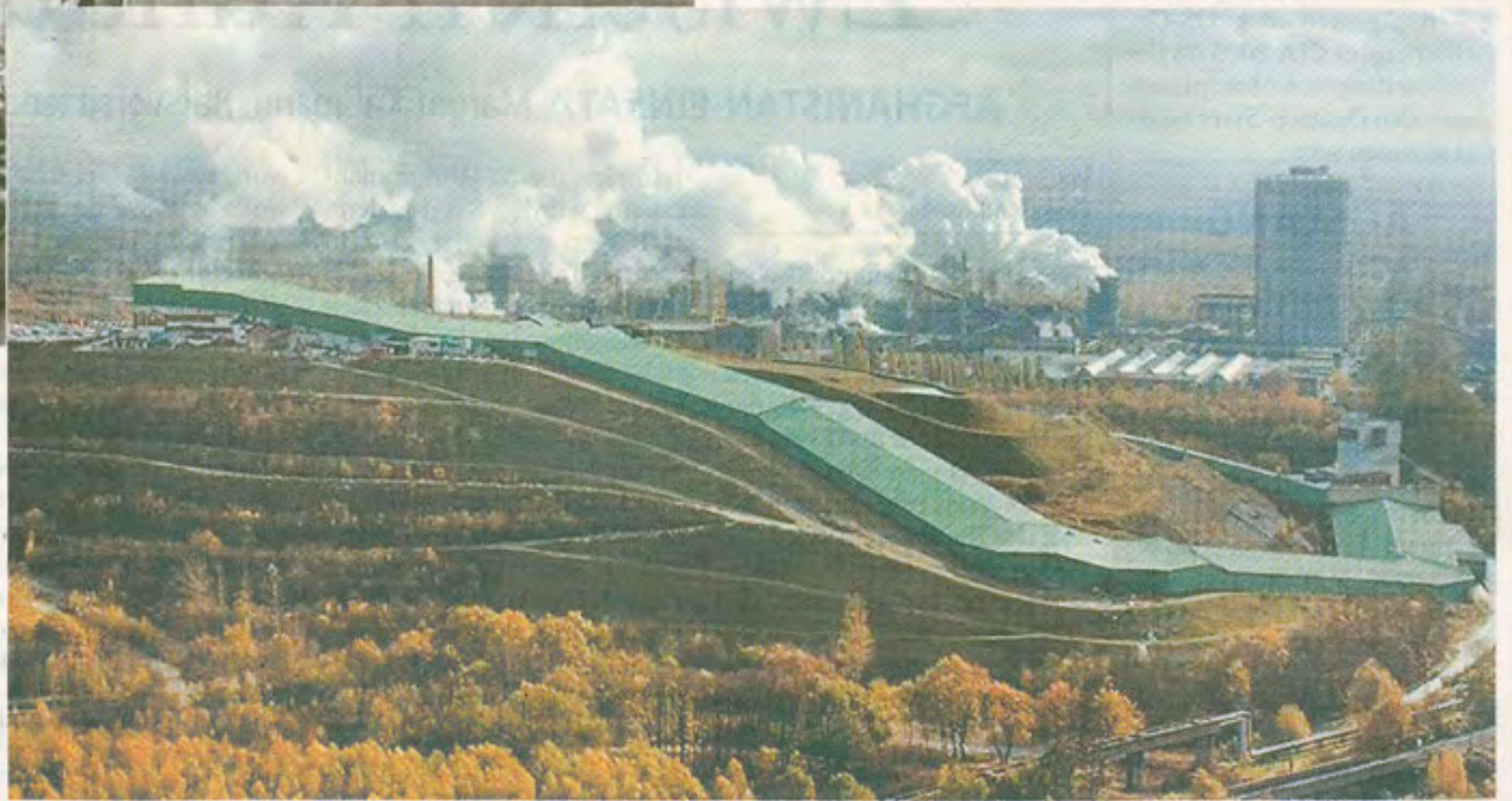
Alpin-Center in Bottrop, größte überdachte Skipiste der Welt, erbaut auf einer ehemaligen Abraumhalde.
